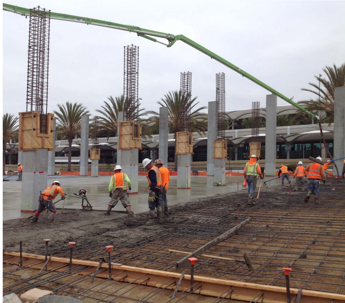
Concrete Pour for Slab on Grade
